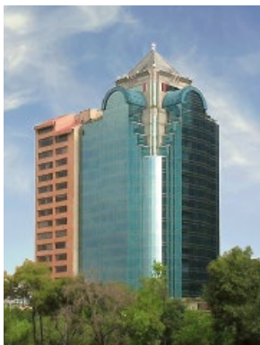
Mexico, Edificio Forum
